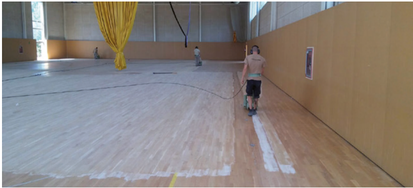
Inici de la feina de restauració a la pista del pavelló. Juny 2016.
